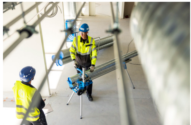
Utöver att montera produkterna handlar en ventilationsinstallatörs dagliga arbete om logistik och samarbete med andra byggaktörer.
